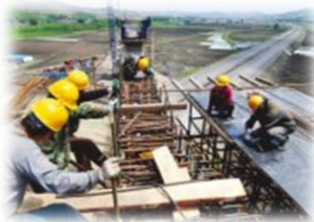
铁路工程建设
